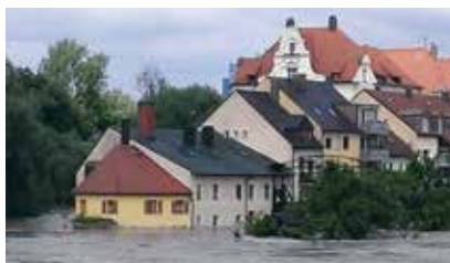
Von Wasser bedrängt: die Wöhrdinsel in Regensburg. (Foto: Kopp)
