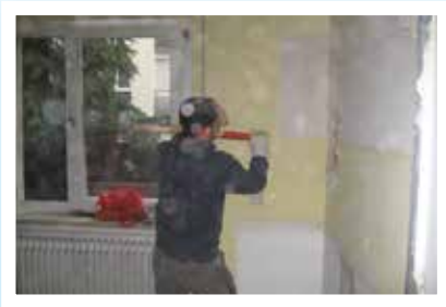
Abbrucharbeiten während des Umbaus
