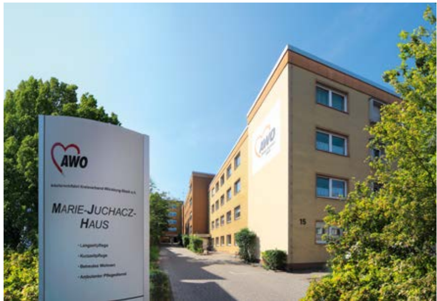
Wird abgerissen und neu gebaut: das Marie-Juchacz-Haus der AWO in Würzburg Foto: AWO-Archiv
