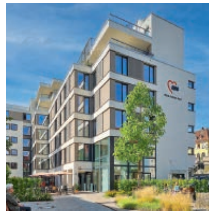
Steht seit fünf Jahren: der Neubau des MJH. Fotos: AWO Unterfranken
